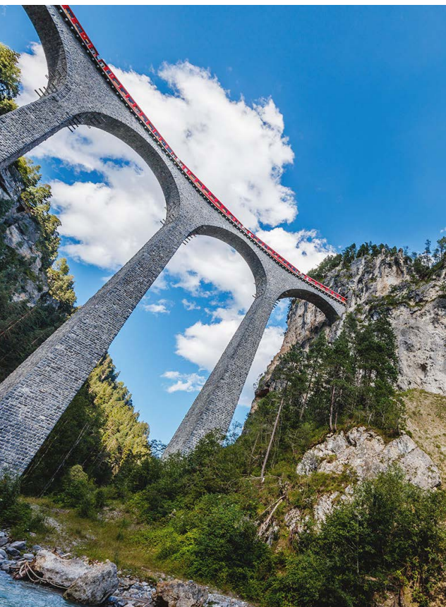
Imposant und eindrücklich: Das bekannte Landwasserviadukt gehört zum UNESCO-Welterbe. © Rhätisch Bahn AG
